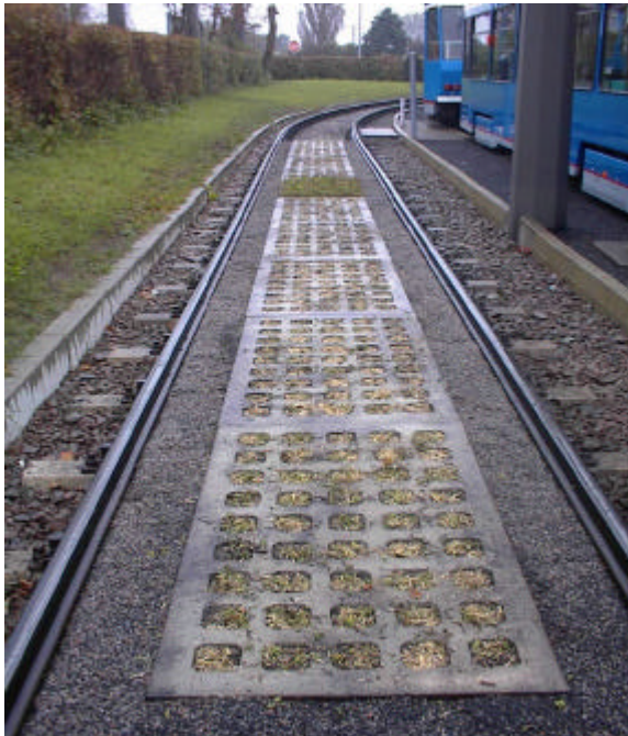
Bild 2: Einbauzustand eines zu Versuchs- und Demonstrationszwecken für die IGA 2003 in Rostock angelegten Gleisabschnittes mit der begrünbaren Gleiseindeckplatte Typ GP System Chemnitz, 15. Oktober 2002
